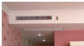
Fluxo de ar frontal, entrada de ar frontal
